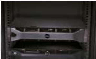
Marcas RU sigue siendo visible después de montar los equipos
