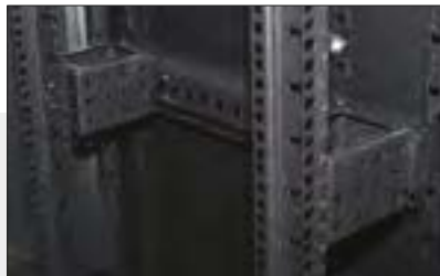
Rieles de montaje ajustables y con espaciador
